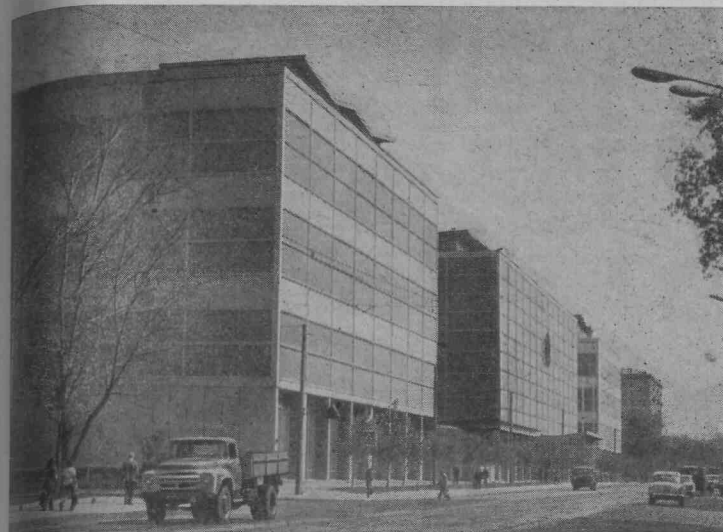
Герметичное производственное здание со стенами из сборных стекложелезобетонных панелей
